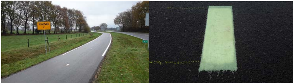
Proefvakken fietsmarkering met kantbelijning en glowing in the dark
