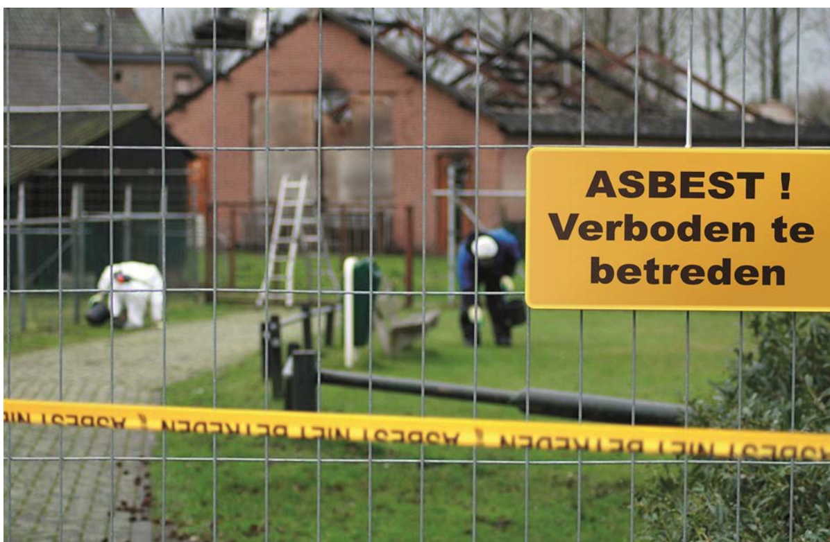
Saneren asbestdaken veiligheidsmaatregelen omgeven (foto: LTO)
