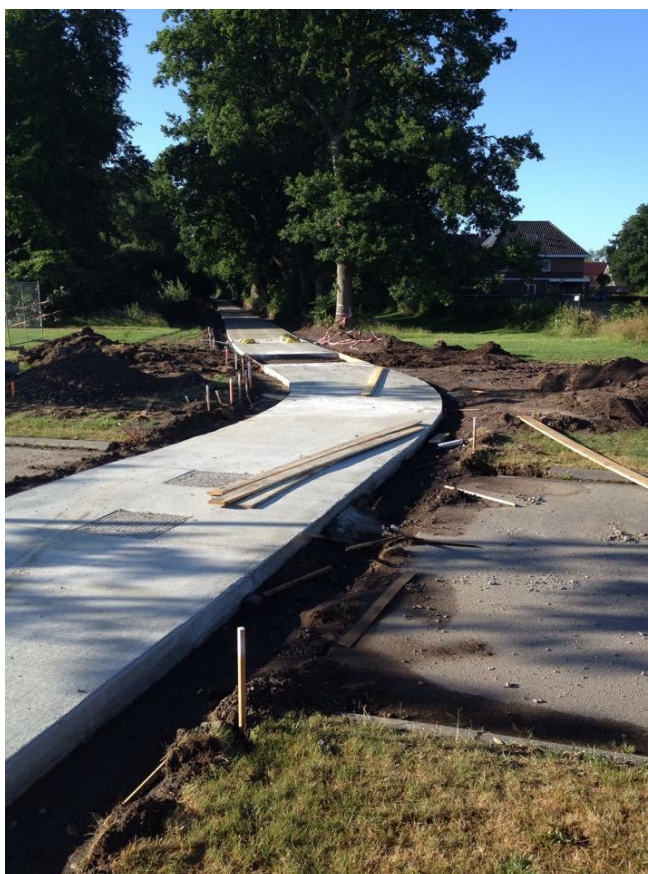
Fietspad naar Hof van Saksen in aanleg
