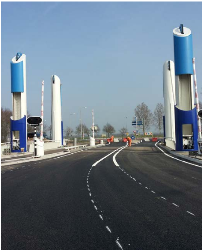
In 2015 oplevering Pijlebrug over Drentsche Hoofdvaart
