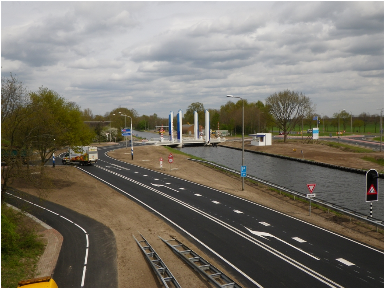
N371 Nieuwe Pijlebrug en reconstructie aansluitende infrastructuur
